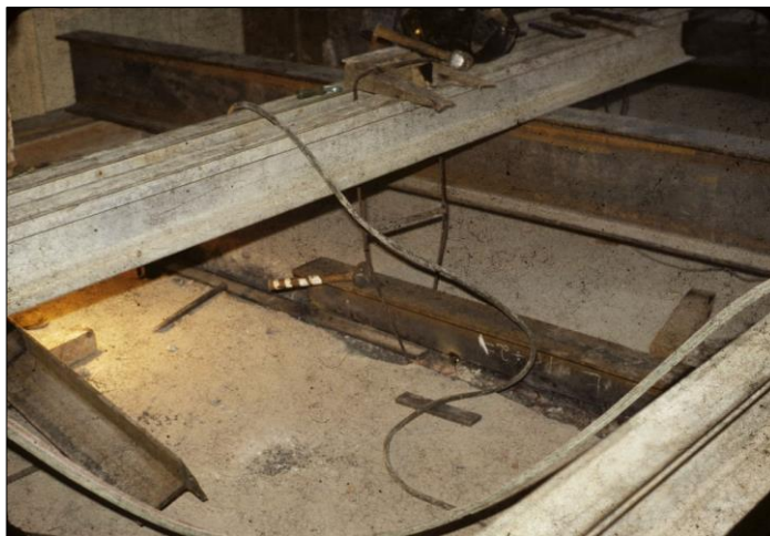
Figura 9.10 – Recuperação das vigas do Palácio Rio Branco.
