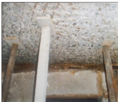
Figura 9.11 – Recuperação de laje em concreto armado com tela deployé na Faculdade de Medicina. A camada inferior de concreto foi removida, assim como toda a tela degradada. Sob a laje existente foi concretada nova laje em concreto armado.
