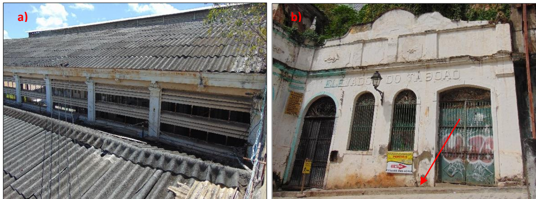
Figuras 7.54 – (a) Calha da Estação da Calçada; (b) condutor vertical de águas pluviais do Elevador do Taboão.
