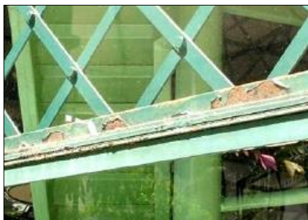
Figura 2.2 – Descascamento da pintura em treliça metálica.
