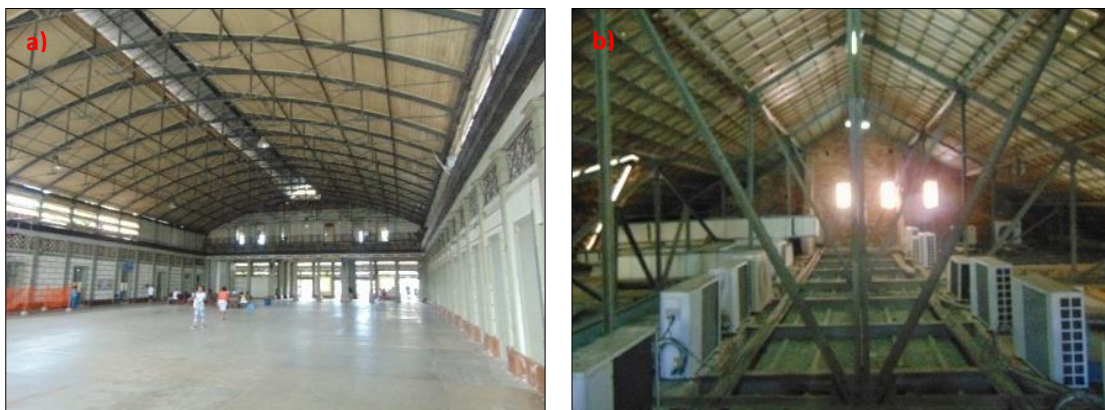
Figura 7.23 – (a) Cobertura com estruturas metálicas na Estação da Calçada; (b) cobertura da ala sul da antiga Faculdade de Medicina.
