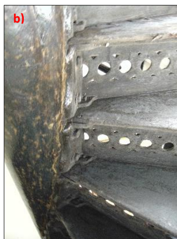
Figuras 7.28 – (a) Vista da escada em ferro fundido da Estação da Calçada; (b) detalhes da conexão peão-degraus da escada em ferro fundido da Estação da Calçada.
