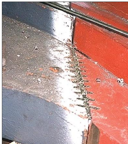
Figura 9.6 – Técnica do stitch repair aplicada na recuperação de peça do Albert Memorial, em Londres.
