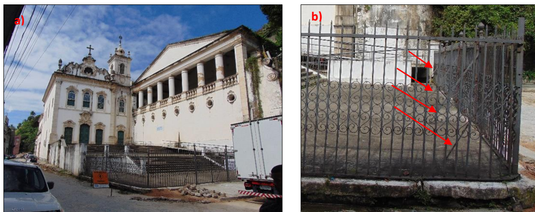
Figuras 7.47 – Gradil do adro da Igreja de Nossa Senhora do Pilar: (a) vista do conjunto; (b) vista parcial lateral do gradil com indicação dos contrafortes.
