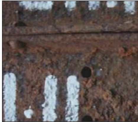
Figura 2.4 – Peça siderúrgica rebitada, sujeita a corrosão por aeração diferencial.
