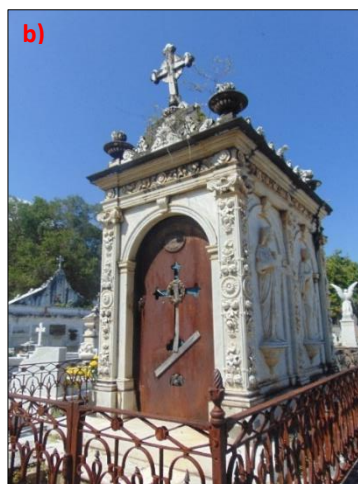
Figuras 7.53 – (a) Esquadria da Estação da Calçada; (b) porta em chapa prensada em mausoléu do Cemitério do Campo Santo.
