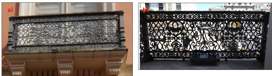
Figura 7.40 – Balcão com gradil, em painel inteiriço de ferro fundido, da Faculdade de Medicina da Bahia; respectivamente, vista do exterior (a) e do interior do edifício (b).
