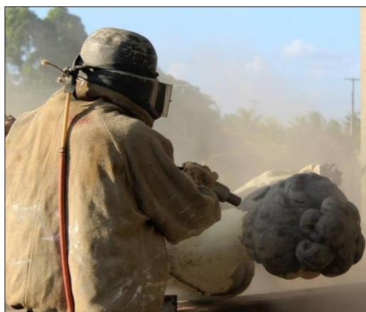
Figura 9.7 – Jateamento abrasivo da imagem da estátua da Deusa Flora, ao grau Sa 2 1/2.
