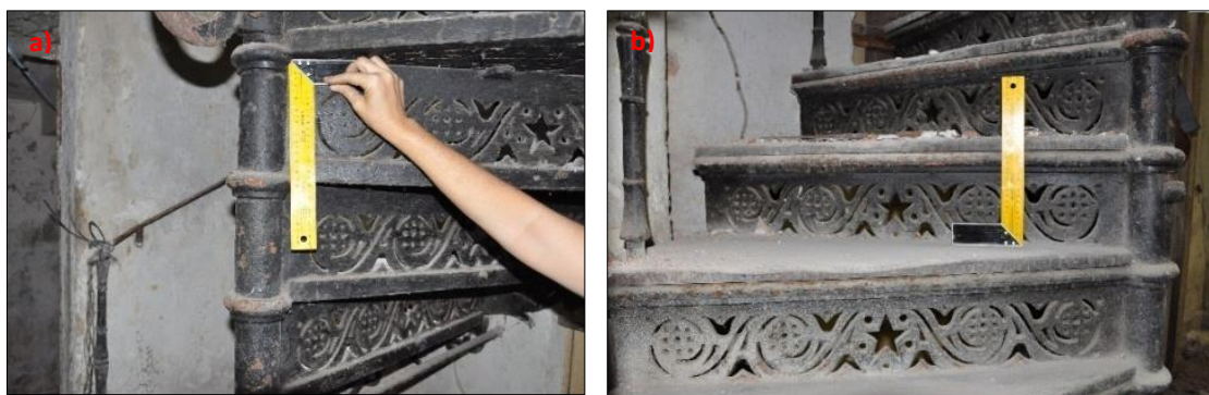
Figura 7.29 – (a) e (b) Degraus da escada em ferro fundido do antigo edifício do jornal A Tarde.
