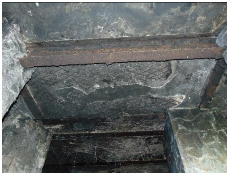
Figura 7.22 – Tela deployé em laje armada do Elevador do Taboão.
