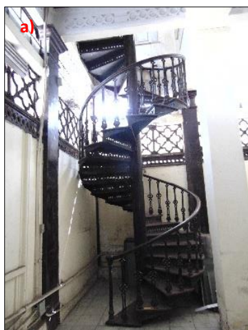
Figuras 7.28 – (a) Vista da escada em ferro fundido da Estação da Calçada; (b) detalhes da conexão peão-degraus da escada em ferro fundido da Estação da Calçada.
